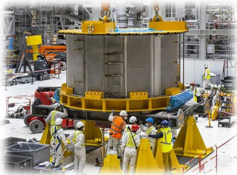
Aimant du Solénoïde Central d'ITER en cours d'assemblage à Cadarache.
