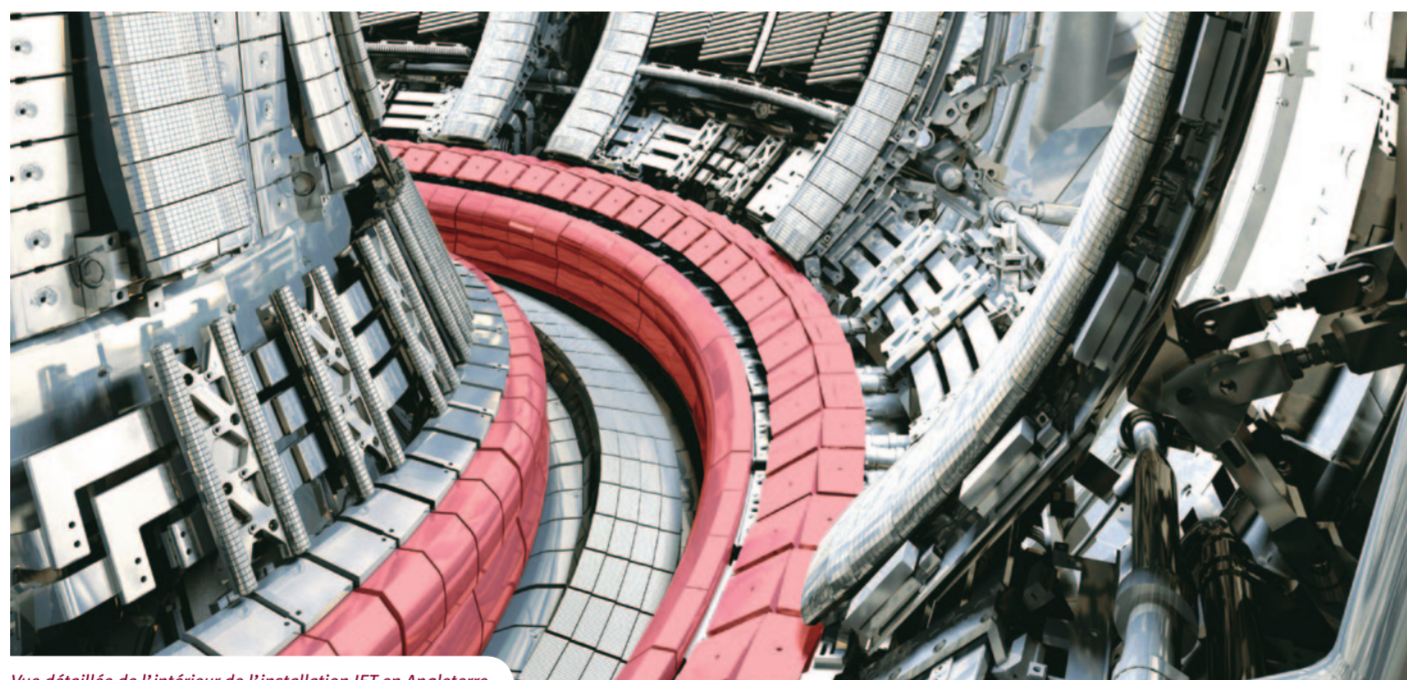
Vue détaillée de l'intérieur de l'installation JET en Angleterre.
