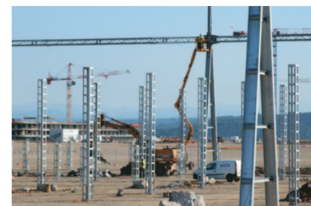
Pose de la poutre de 5 tonnes.
